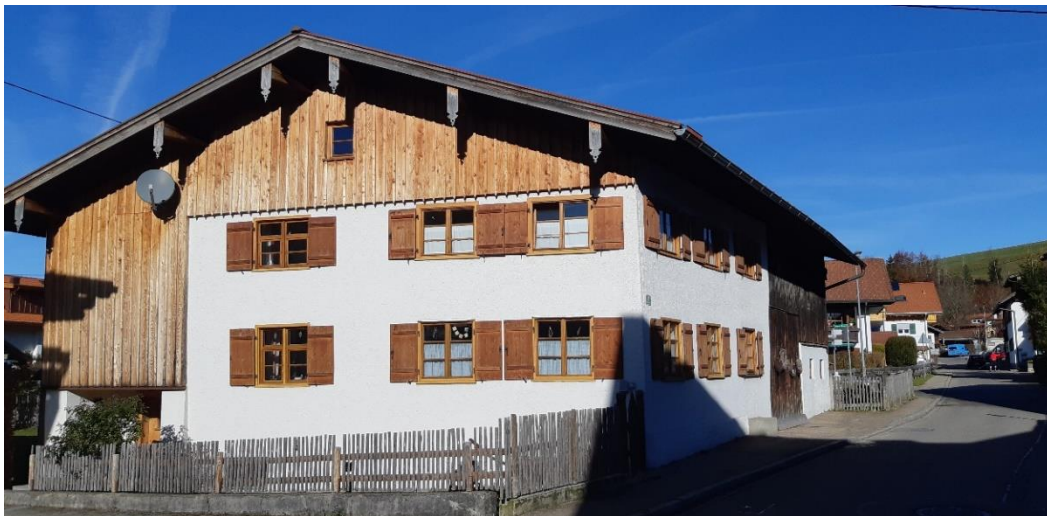
Am Naglerweg 11, Südansicht
