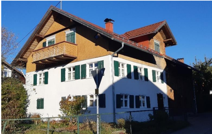
Am Naglerweg 12, Südwestansicht
