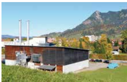
Holzheizkraftwerk am Binse
