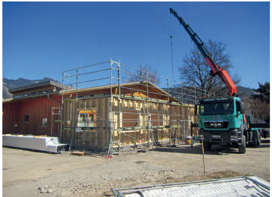
Baufortschritt beim Kinderhaus Regenbogen: Das gute Wetter wurde für die Aufrichtarbeiten genutzt
