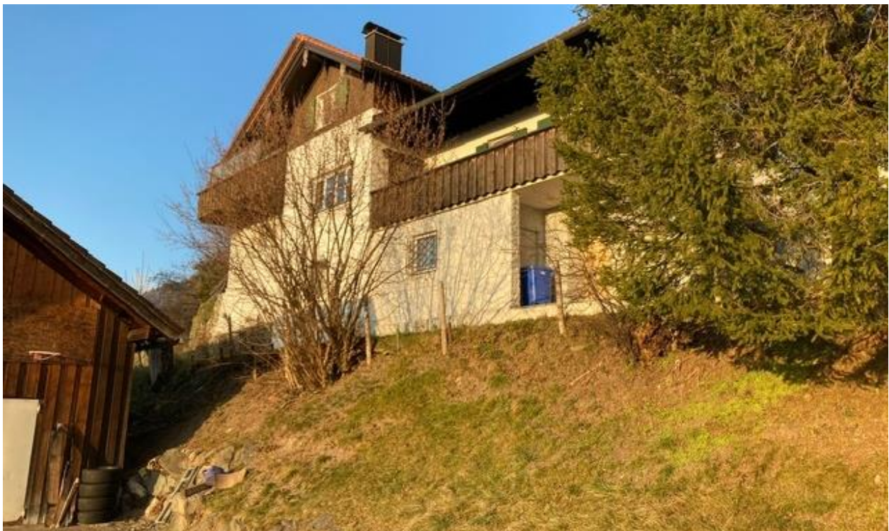
Abbildung 6: Anstelle des Gebäudes am linken Bildrand entsteht der Neubau mit Heizzentrale. Am rechten Bildrand befindet sich das Bestandsgebäude Burgweg 3
