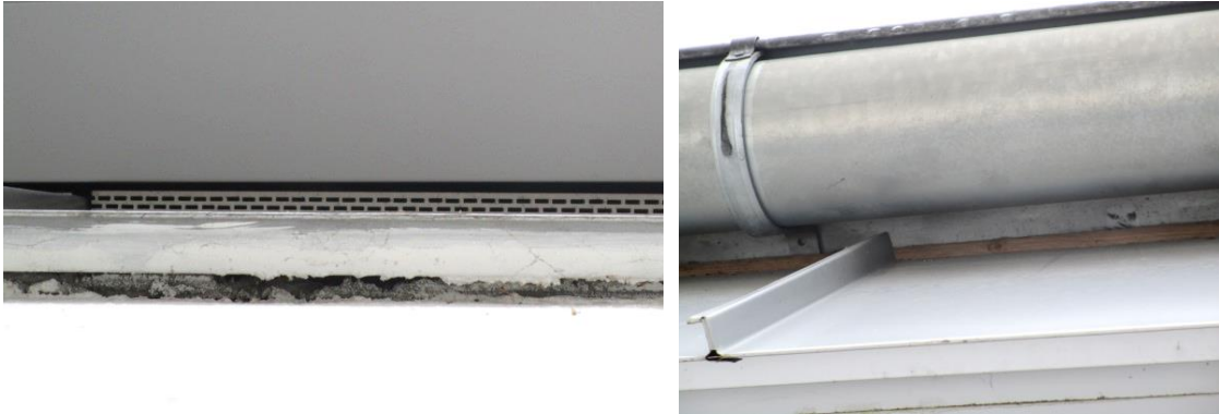
Abbildung 10: Fotos der für Fledermäuse relevanten Strukturen am zu untersuchenden Gebäude, 17.03.2021
