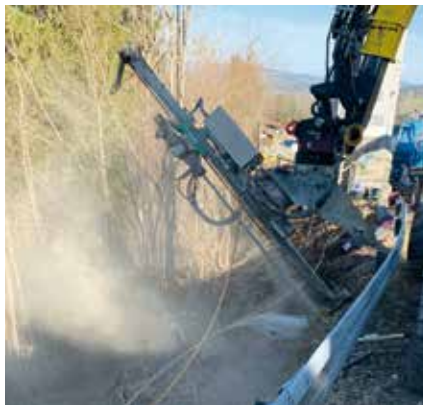
Arbeiten an der Kapellenkurve Imberg
