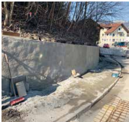
Hangsicherung an der Hofener Straße
