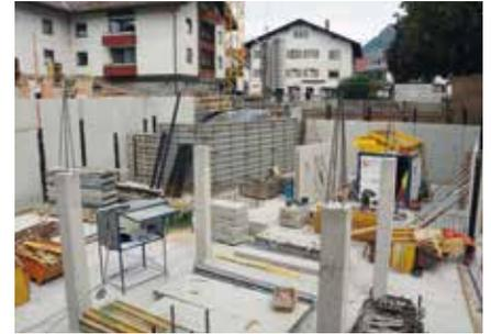
„Unterirdisch“ geht es voran: Die Bodenplatte für das Fundament wird gegossen, die Kellerwände werden geschalt und der Fahrstuhlschacht für das künftig barrierearme Museum ausgehoben.
