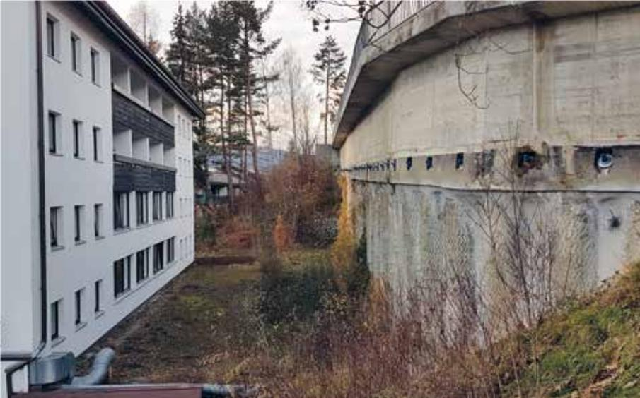
Das Foto zeigt einen Teil der rund 60 m langen und 8 m hohen Bohrpfehlwand oberhalb des AllgäuStern Hotels
