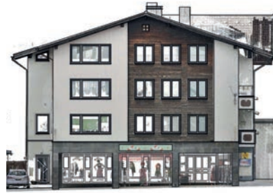
Beispiel einer farblichen Gestaltung eines Wohn- und Geschäftshauses
