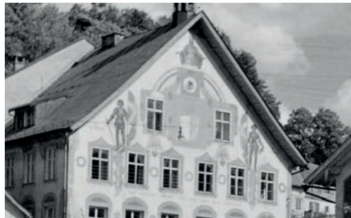
Historische Fassadenmalerei (Ausschnitt aus Foto Heimhuber)
