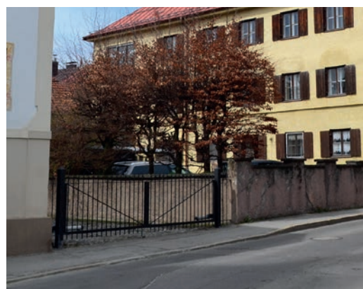
Historische Mauer und neuer Zaun entlang der Straße
