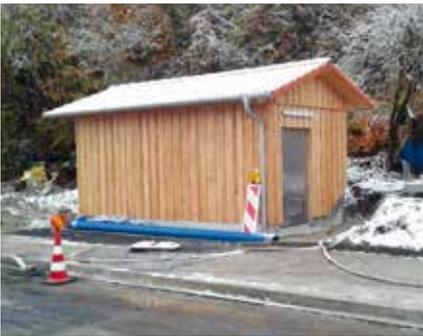
förderung beträgt ca. 55.000 Kubikmeter, die Förderhöhe (Standort Pumpstation bis Hochbehälter) 101 Meter. Für das Erneuern der Pumpstation sind 225.000 Euro eingeplant. Das Gebäude ersetzt das bisherige unterirdische Schachtbauwerk.
