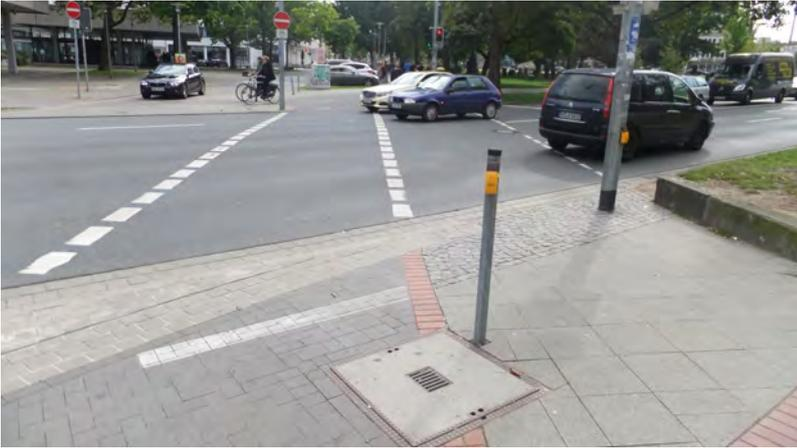
Abb. 92: Fahrradfreundliche Anordnung des Ampeltasters für den Radverkehr.
