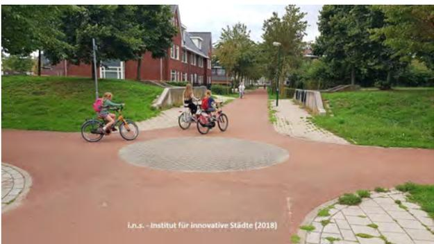
Abb. 51: Aufgepflasterter Kreisverkehr am Knotenpunkt zweier Radwege (überfahrbar)
