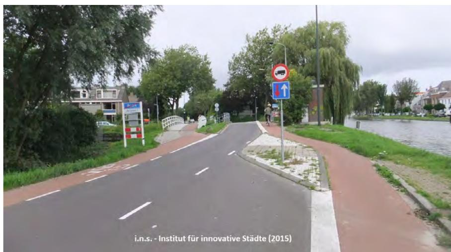
Abb. 54: Durchgängigkeit der Radverkehrsführung durch Verringerung der Fahrbahnbreite für den Kfz-Verkehr.
