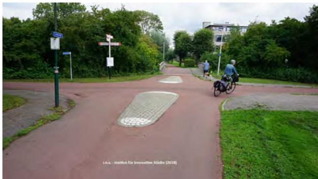
Abb. 50: Aufgepflasterte Mittelinseln aus den „untergeordneten“ Radwegen
