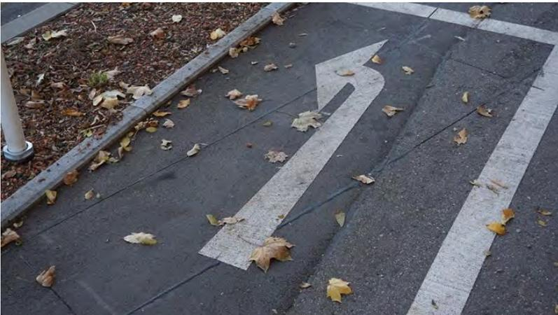
Abb. 93: Induktionsschleife für den Querverkehr auf einem Radweg
