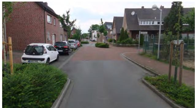
Abb. 18: Mit Grüninseln werden in dieser Tempo 30-Zone eine Torsituation geschaffen und die Sichtachsen unterbrochen, so dass sich die Geschwindigkeiten reduzieren. Die Parkstände sind baulich ausgebildet und ordnen den Verkehrsraum. Im Einmündungsbereich erfolgt ein Materialwechsel von Asphalt auf Pflastersteine.
