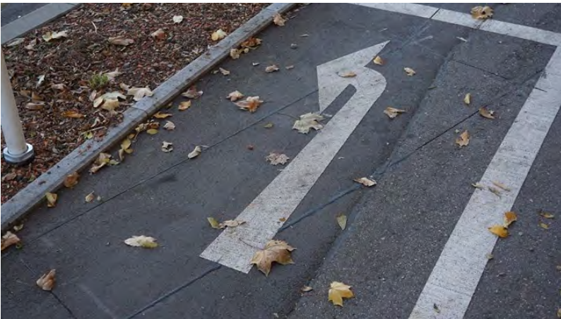
Abb. 93: Induktionsschleife für den Querverkehr auf einem Radweg
