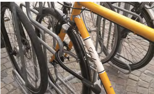
Abb. 77: Ist der Bügel zu kurz, kann das Fahrrad mit einem kurzen Schloss nicht mehr sicher am Rahmen angeschlossen werden. Bei der Auswahl eines Abstellsystems ist daher auf einen langen Bügel zu achten.
