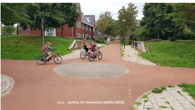
Abb. 51: Aufgepflasterter Kreisverkehr am Knotenpunkt zweier Radwege (überfahrbar)
