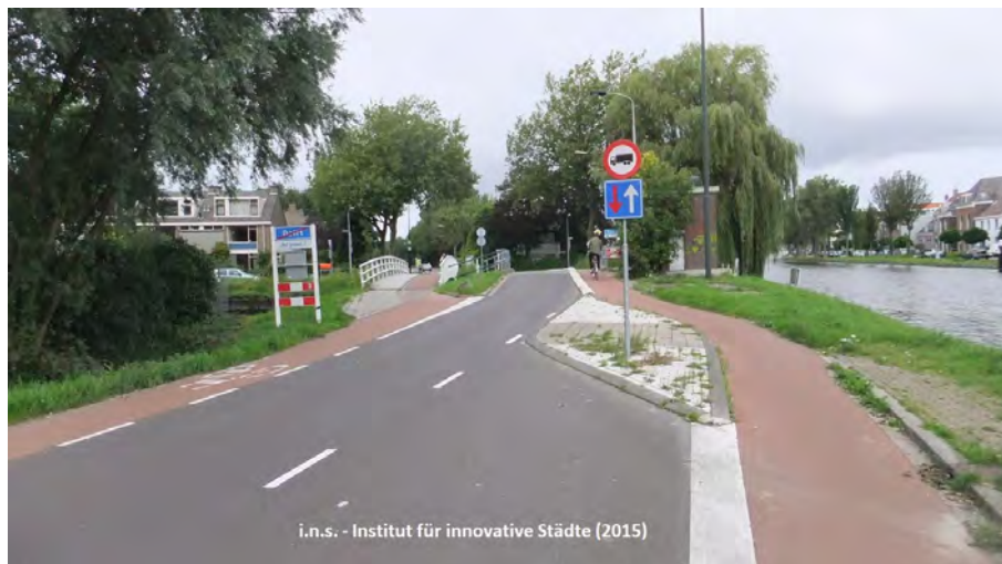
Abb. 54: Durchgängigkeit der Radverkehrsführung durch Verringerung der Fahrbahnbreite für den Kfz-Verkehr.
