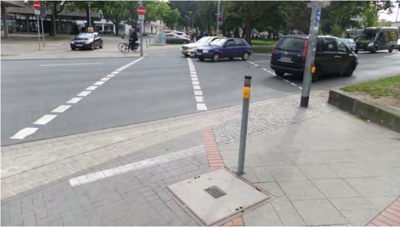
Abb. 92: Fahrradfreundliche Anordnung des Ampeltasters für den Radverkehr.
