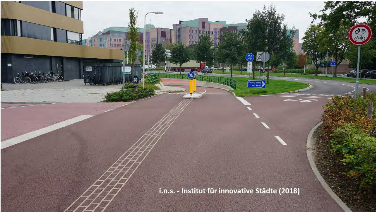
Abb. 56: Ende einer Fahrradstraße mit seitlicher Ausleitung des Kfz-Verkehrs und baulicher Überleitung des Radverkehrs in einen Radweg (geradeaus).
