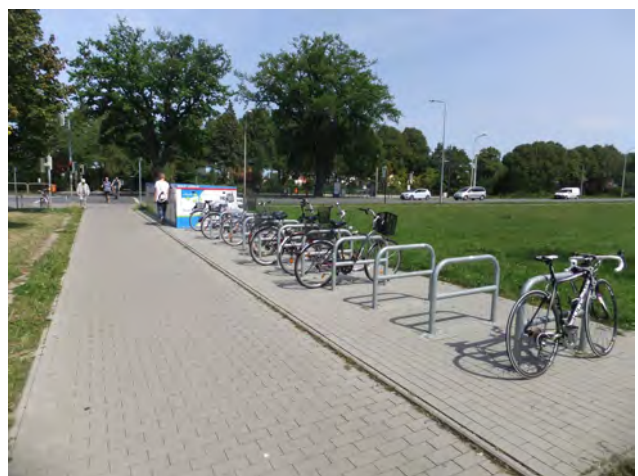
Abb. 78: Anlehnbügel mit Rundrohr reduzieren das Schadenrisiko an den abgestellten Fahrrädern, ein Querholm erleichtert das Anschließen von Kinder- oder Lastenfahrrädern.
