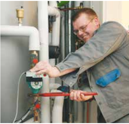
Einbau einer neuen Hocheffizienzpumpe. Quelle: eza!
