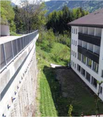
Unser Foto zeigt links einen Teil der Bohrpfahlwand, rechts davon einen Teil des AllgäuSternHotels
