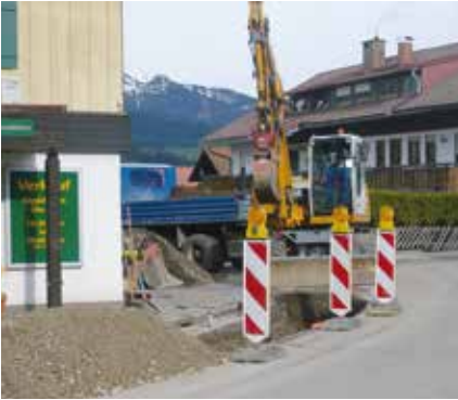
Herstellen des Grabens für die neue Wasserleitung
