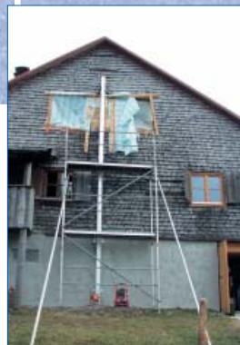
Sanierung des „Sonthofer Hofes“ - Erhalt der städtischen Alphütte
