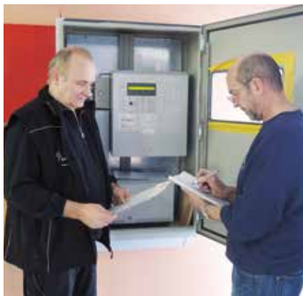
Haustechniker Philipp Holderied und Stellvertreter Heribert Stöcklein beim Check der Gebäudetechnik
