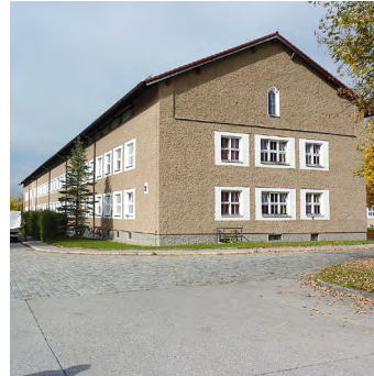
Erhaltenswertes Gebäudeensemble, Jägerkaserne (links)
